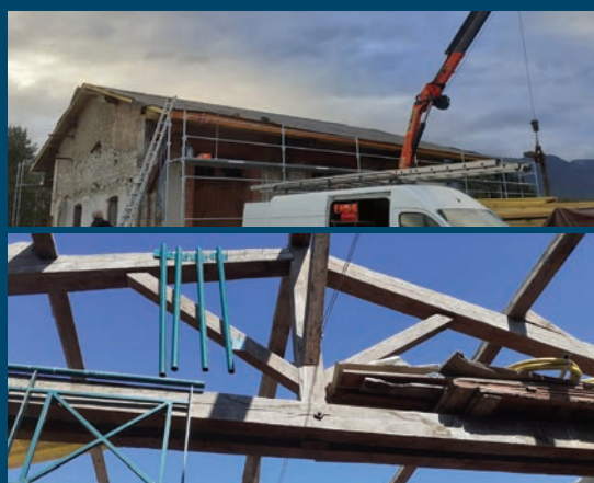
Toiture de la gare
