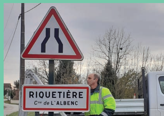
Pose de panneaux Hameau Riquetière
