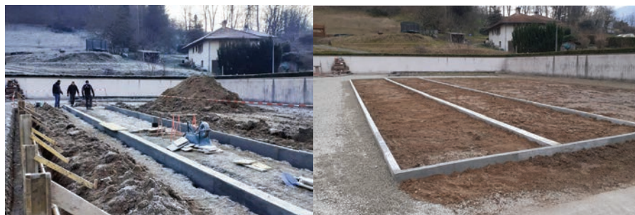
Travaux du cimetière
